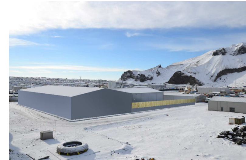
Ásýnd á norðurhlíð lóðar Kleifa 2 með nýbyggingu. Nýbygging er 2m hærrí en aðrar byggingar á deiliskipulagsvæðinu og 3.780 m 2 að stærð.
